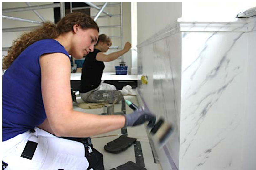
Het aanbrengen van een imitatie van witmarmer.
