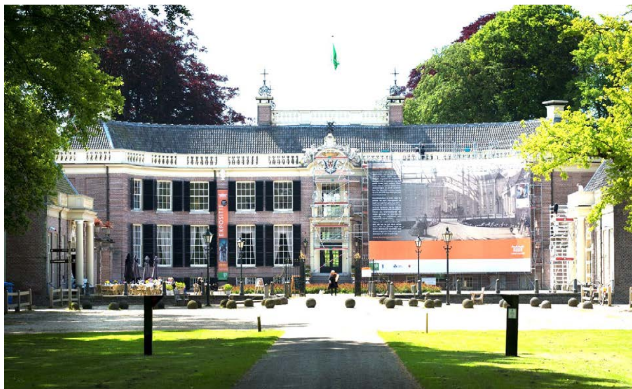
Onderhoud en restauratie van schilderwerk aan monumenten.
