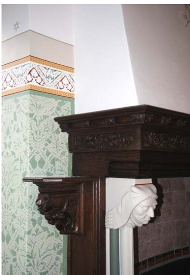
Binnenschilderwerk op steen afgewerkt met decoratief sjabloneerwerk.
