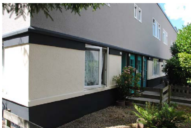
Buitenschilderwerk op beton.
